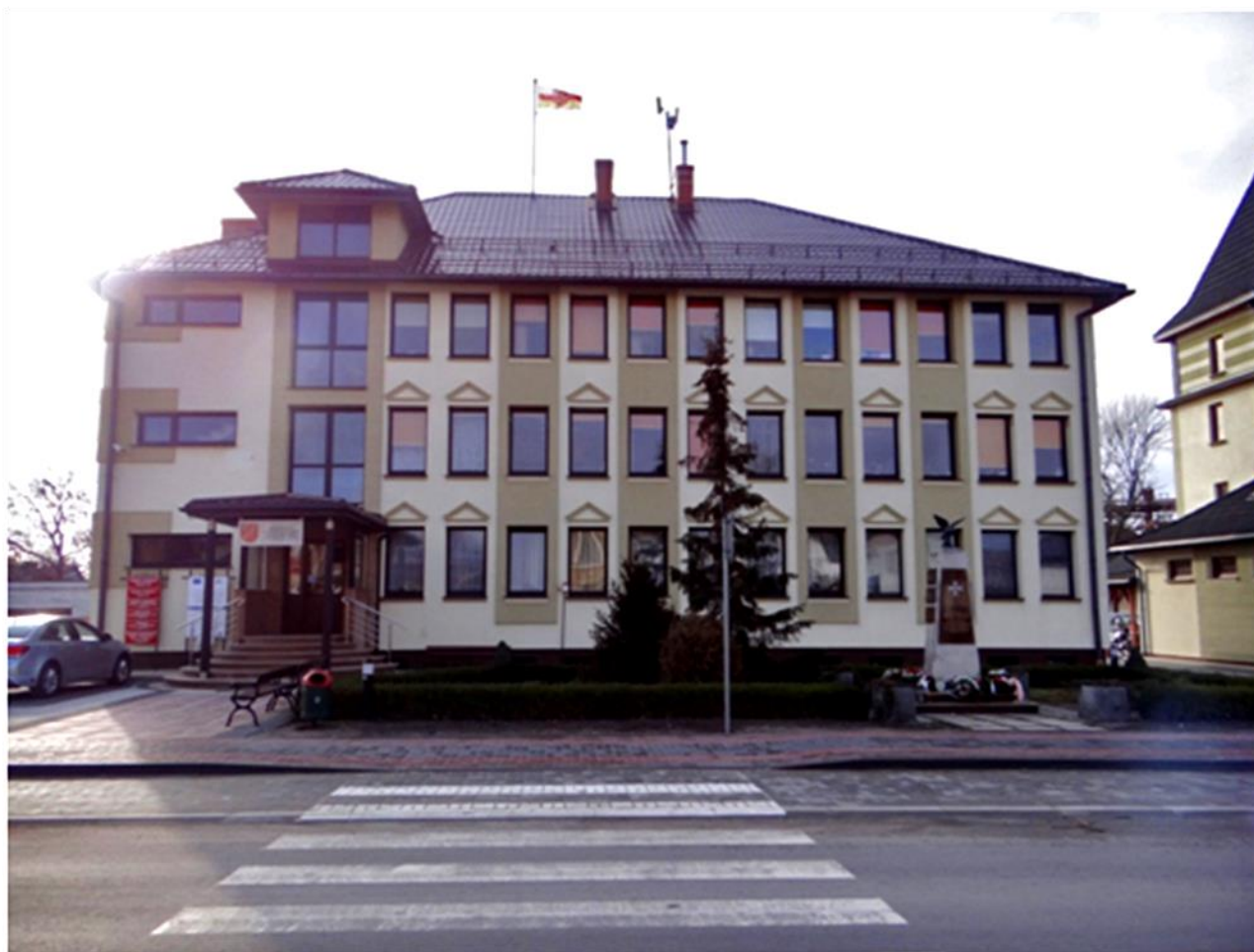
Rysunek 18. Budynek Urzędu Gminy Mircze po pracach termomodernizacyjnych i remontowych
