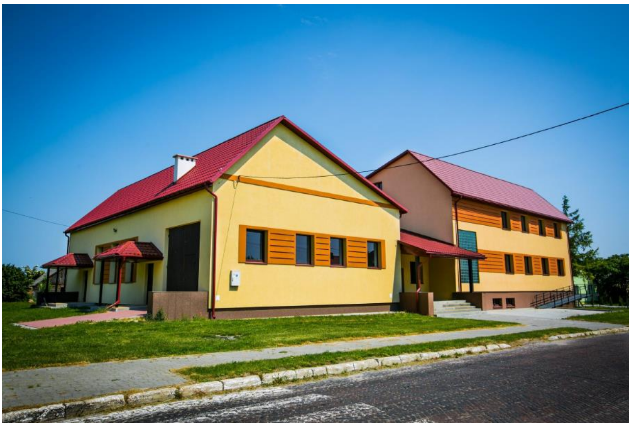
Rysunek 20. Budynek remizo-świetlicy po pracach termomodernizacyjnych i remontowych
